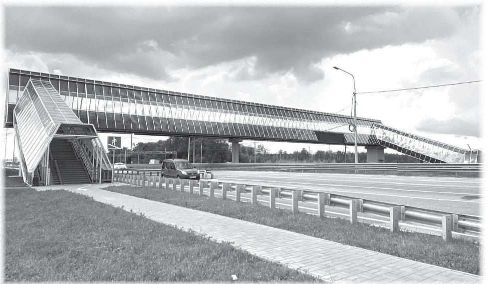
Строительство надземных пешеходных переходов на автомобильной дороге А-134 подъездная дорога от автомобильной дороги М-4 «Дон» к г. Воронежу на км 4 + 700, км 6 + 500, км 8 + 150, Воронежская область (заказчик-застройщик ООО «НАВАСТРОЙ», генеральный директор Н.В. Нахатакян; проектная организация ООО «Центр-Дорсервис», генеральный директор М.А. Карпович) – номинация «Лучший реализованный проект. Объект транспортной инфраструктуры»
